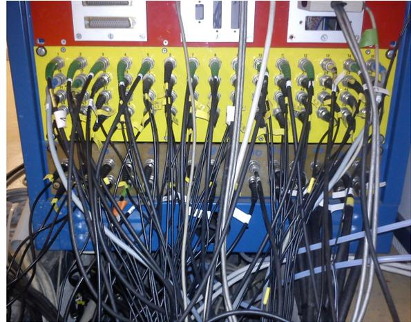
(b) Gelbes und braunes Shielding der Durchführung aus der Messhalle zum Messraum.
